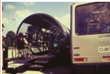
库里蒂巴独特的管筒车站：车站月台与巴士地板在同一水平面，乘客快捷地上下车，在车站上安装残疾人乘车的升降梯，即减轻巴士重量又简化维护工作
